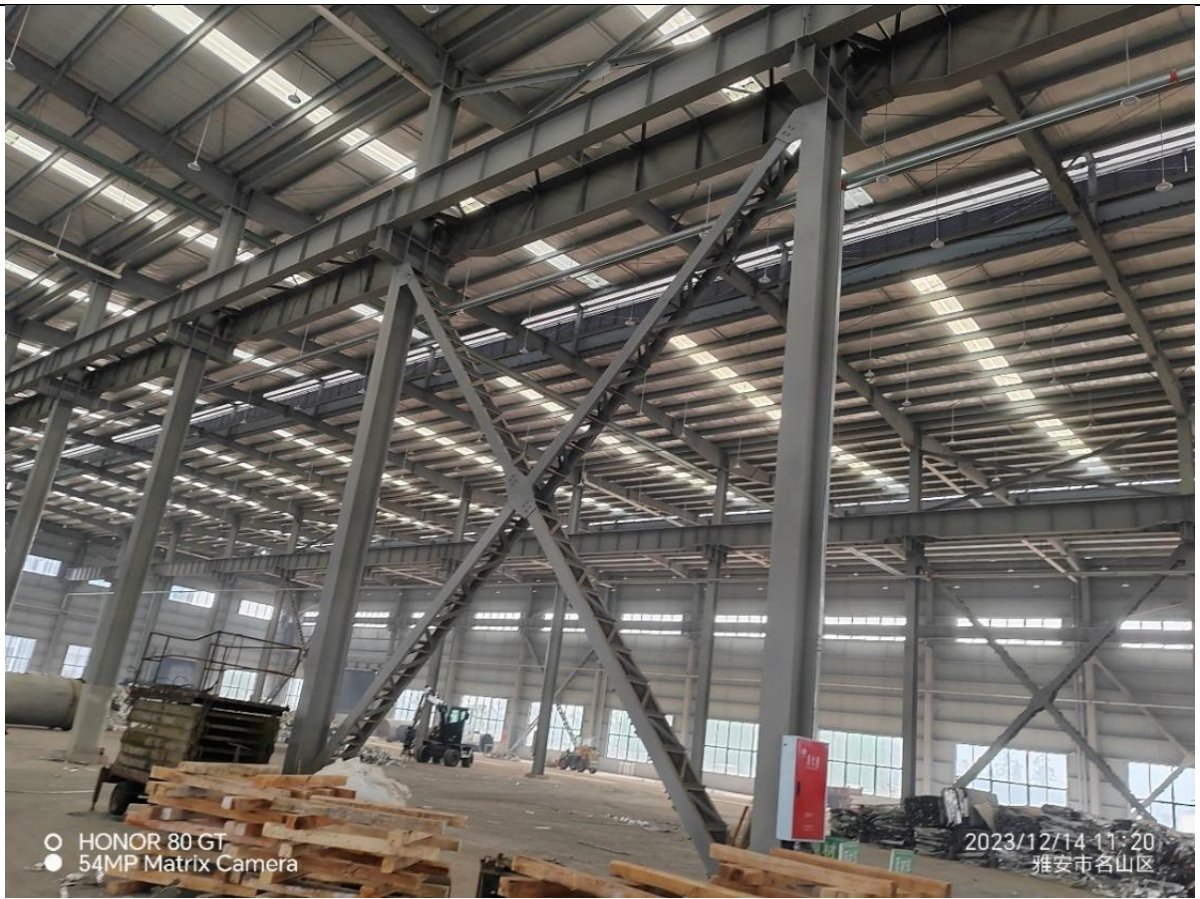
图 二-12 3#生产车间现状照片
