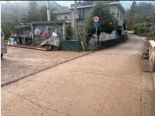
道路工程建设现状
