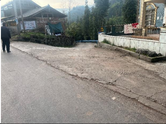
道路工程建设现状
