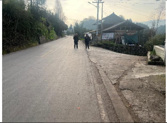
道路工程建设现状
