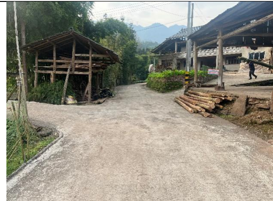
道路工程建设现状
