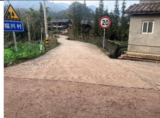
道路工程建设现状
