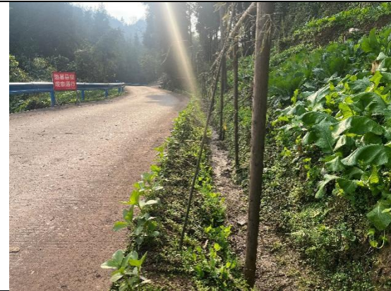
道路工程建设现状
