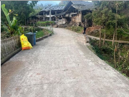
道路工程建设现状
