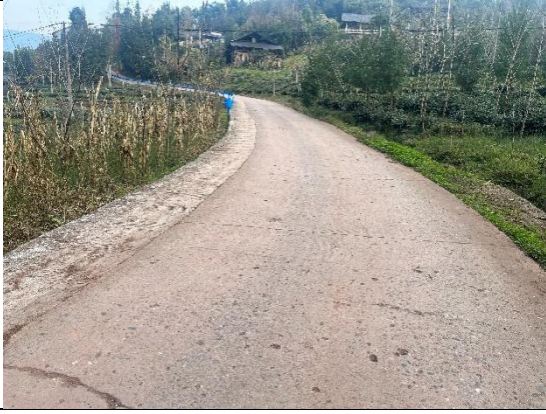
道路工程建设现状
