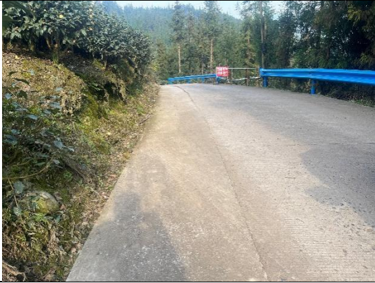
道路工程建设现状
