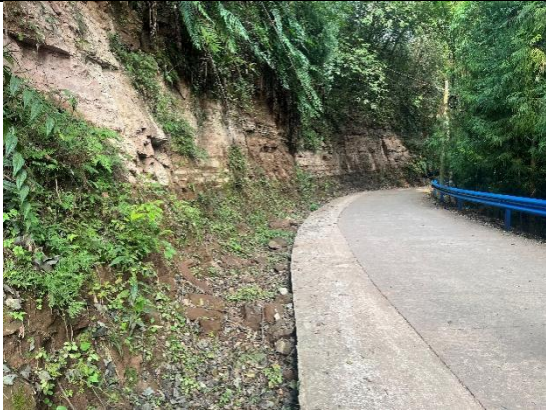
道路工程建设现状
