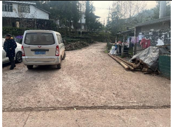
道路工程建设现状
