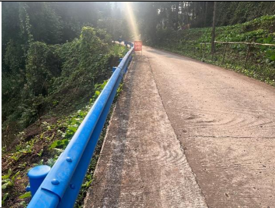
道路工程建设现状
