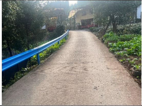
道路工程建设现状
