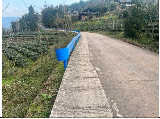
道路工程建设现状
