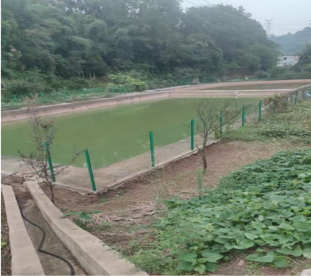
排水沟及沉砂池照片
