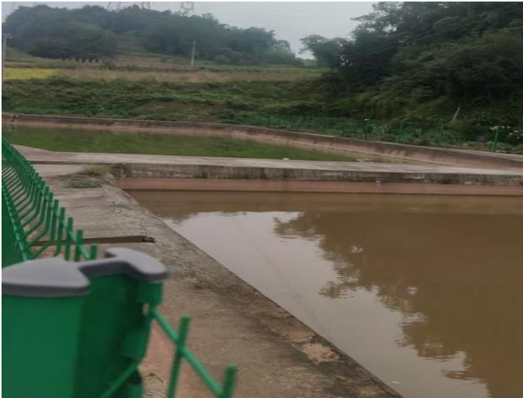
排水沟及沉砂池照片
